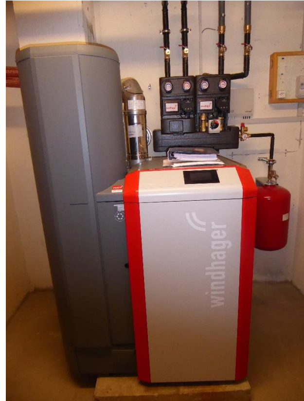
Chaudière à pellets
